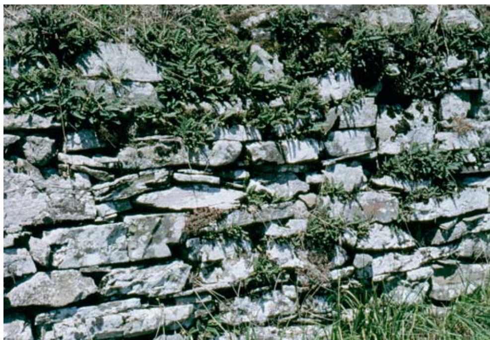
Fig. 23. Vecchio muro a secco.
